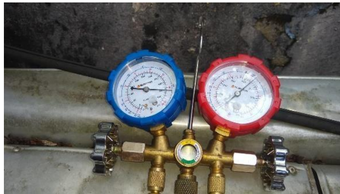
Foto Equalização do sistema após reparo.
