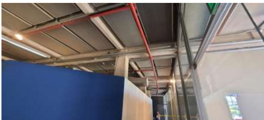
Na sala de exposições, onde iniciamos os trabalhos; com os furos de sustentação da tubulação de abastecimento do sistema.
