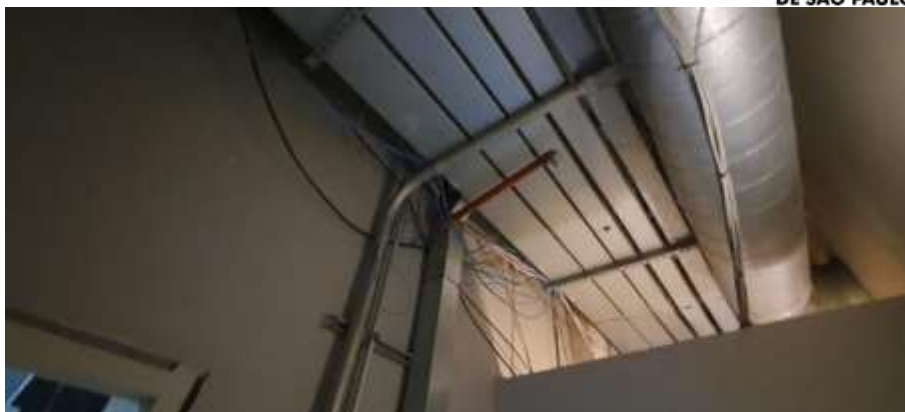
Aqui já instalado alguns bicos nos fundos (corredor) das salas.
