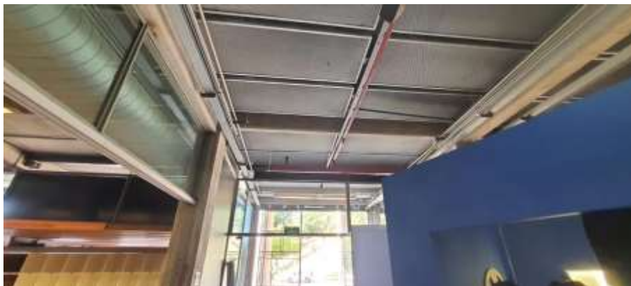
Imagens da rede já executada na sala de exposições.
