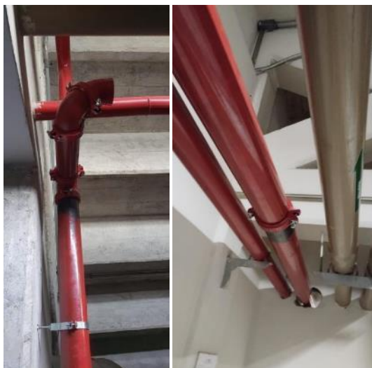
Acesso vertical da tubulação com tubos longos, conexões e fixação.
